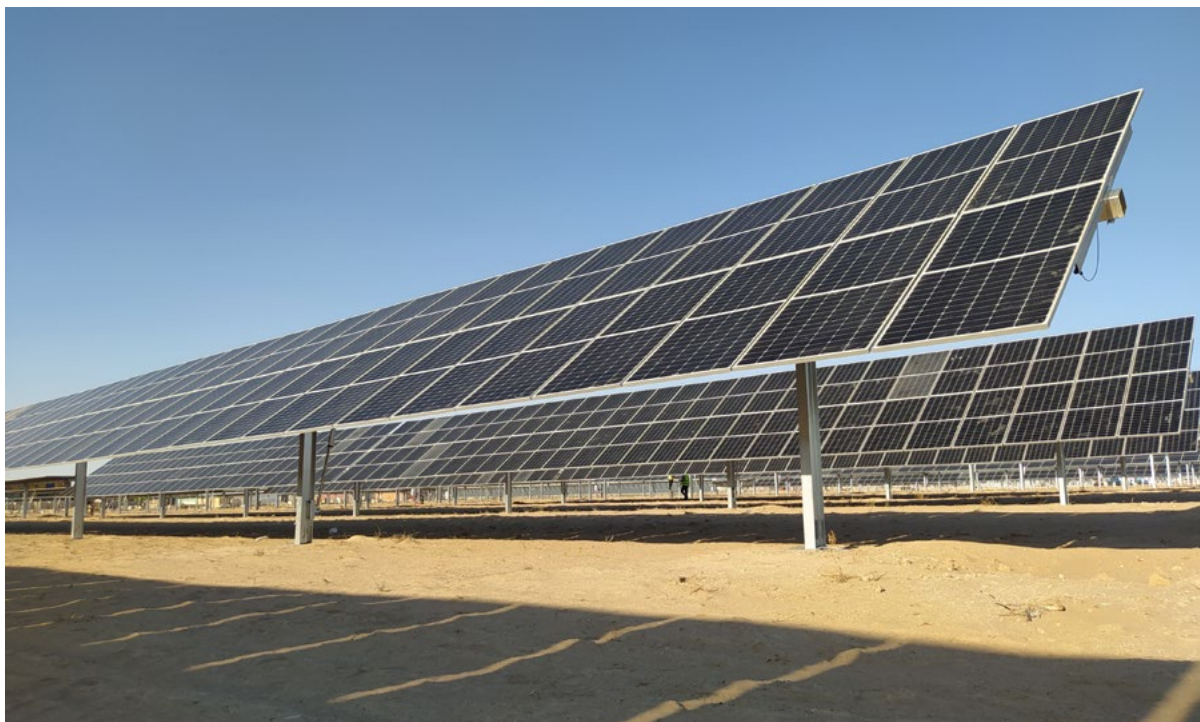
Рисунок 14. Установка солнечных панелей
